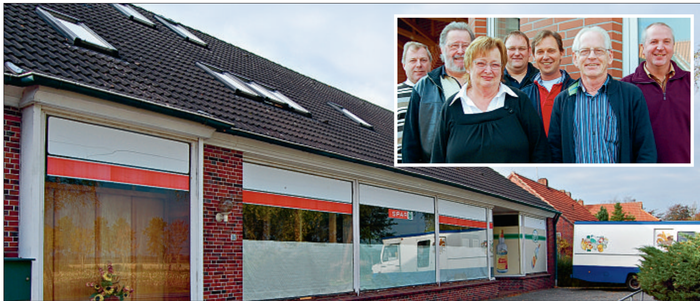
In den Räumen des ehemaligen Lebensmittelgeschäfts von Familie Backer soll das Großheider Kontor eingerichtet werden. Mehrere Ehrenamtliche (kleines Foto) wollen zum Erfolg der Einrichtung beitragen. FOTOS: HEINENBERG
